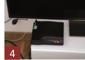
4 Installation de l'équipement (adaptateur fibre optique) et fin de notre intervention
