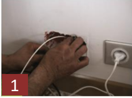
1 Passage de la fibre dans les gaines ou en apparent
